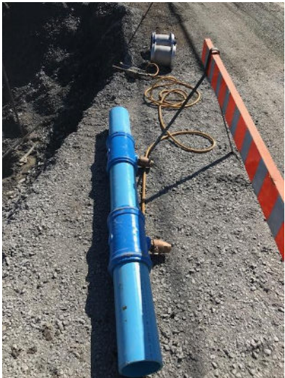
Matériaux utilisés pour la réparation
