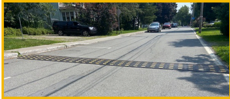
Dos d'âne sur la rue Pleasant Speed bump on Pleasant Street
