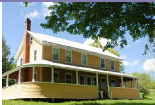
MAISON PRENTICE : 208, CHEMIN NORTH SUTTON
