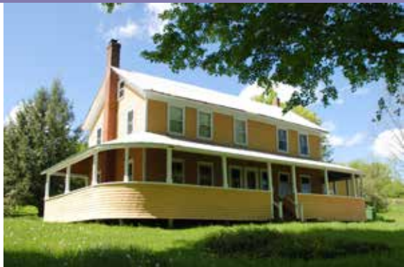
MAISON PRENTICE : 208, CHEMIN NORTH SUTTON
