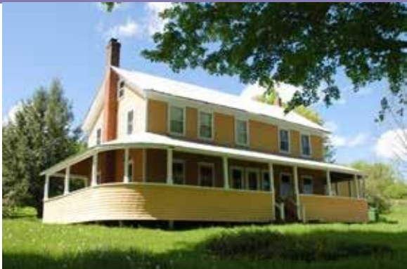
MAISON PRENTICE : 208, CHEMIN NORTH SUTTON
