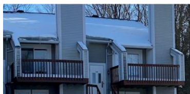
Détails: Balcon en fibre de verre gris, rampes en aluminium noir + soffites noir sous le balcon
