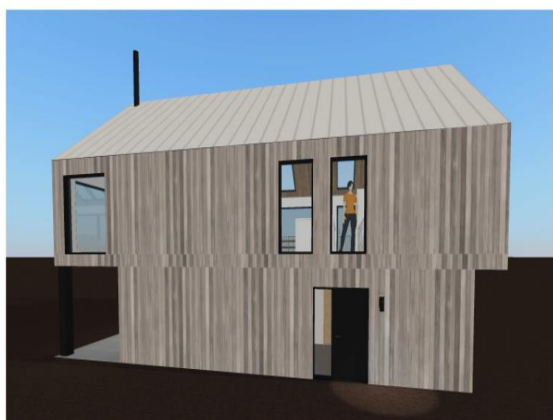
Toiture en acier grise et parement en cèdre pré-veilli
