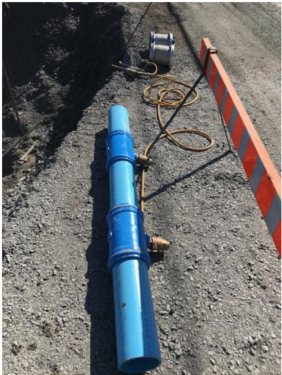
Matériaux utilisés pour la réparation
