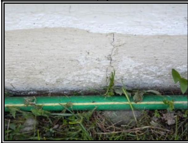
C-18 : CG 296 façade arrière
