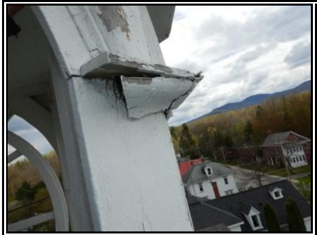
C-133 : CG 502 toiture
