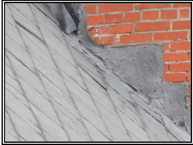
C-204 : CG 518 toiture
