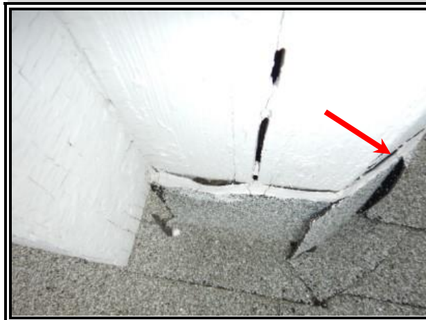
C-120 : CG 498 toiture
