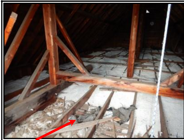
C-164 : CG 486 toiture
