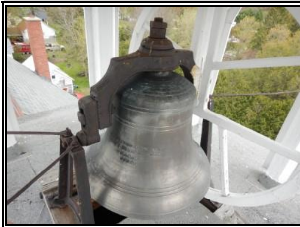
C-162 : CG 510 toiture
