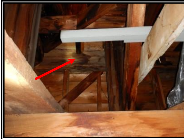
C-42 : CG 526 toiture
