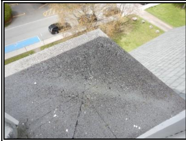
C-118 : CG 496 toiture
