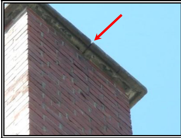
C-205 : CG 300 façade arrière
