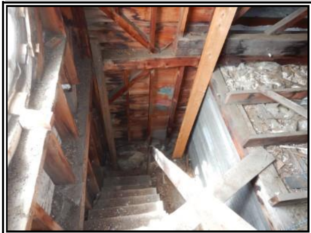
C-45 : CG 484 toiture
