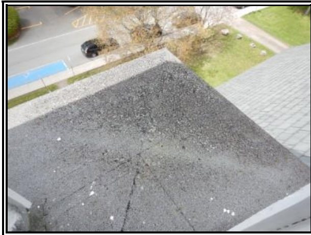
C-114 : CG 496 toiture
