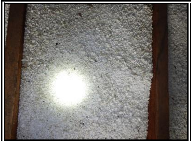
C-49 : CG 535 toiture
