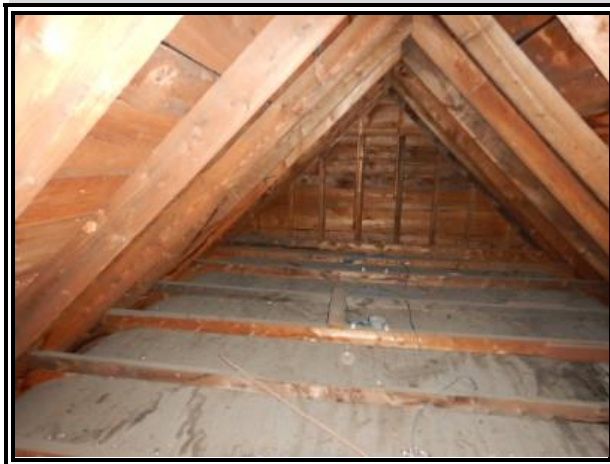
C-40 : CG 543 toiture
