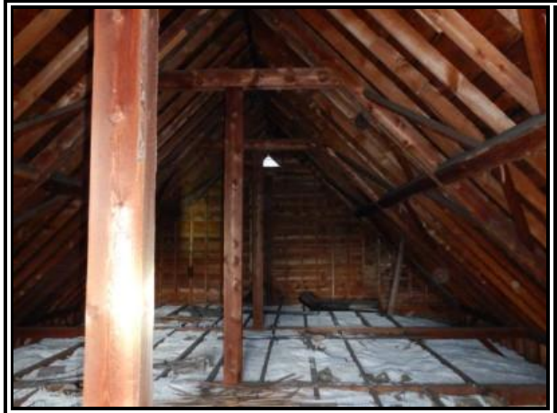
C-47 : CG 532 toiture
