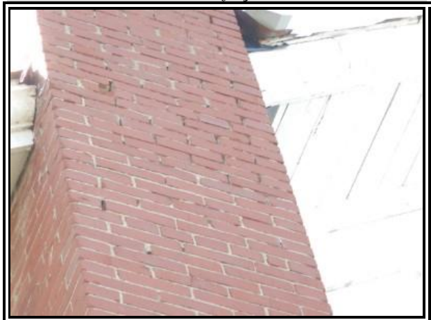
C-200 : CG 299 façade arrière
