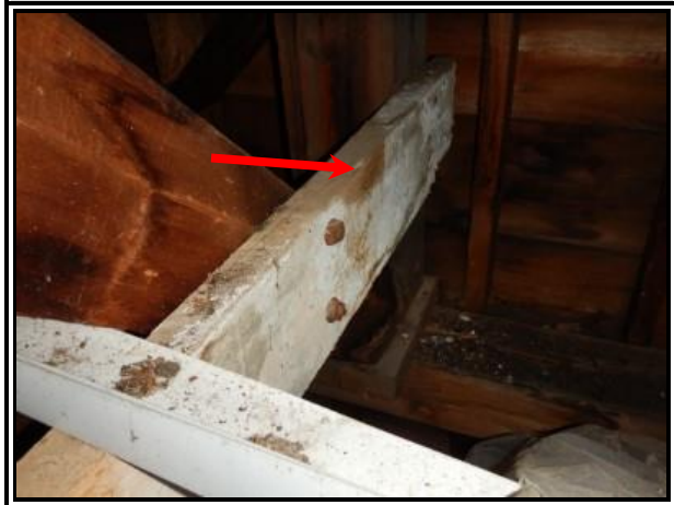
C-43 : CG 525 toiture
