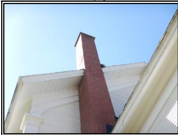
C-199 : CG 298 façade arrière
