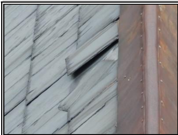
C-158 : CG 519 toiture
