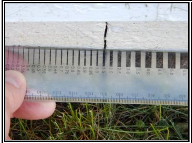
C-17 : CG 290 façade arrière
