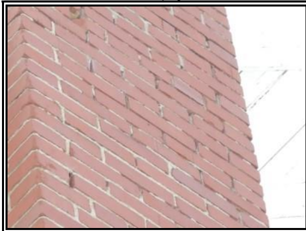
C-201 : CG 304 façade arrière
