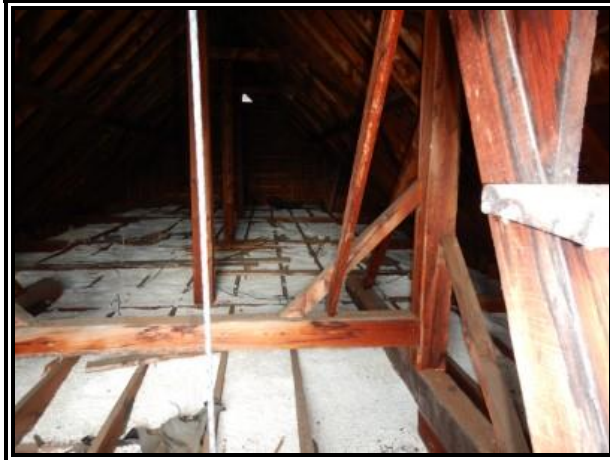
C-46 : CG 489 toiture
