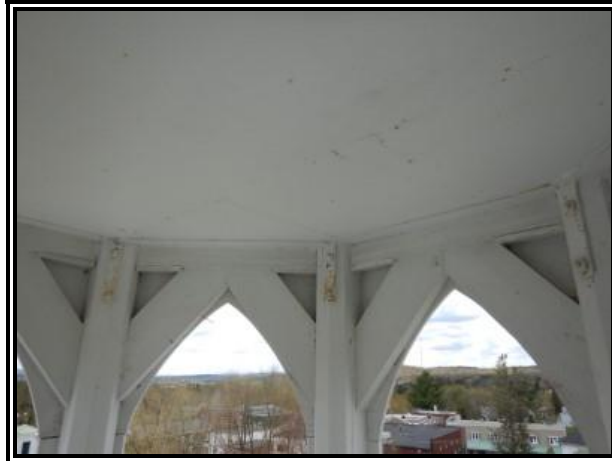
C-132 : CG 495 toiture
