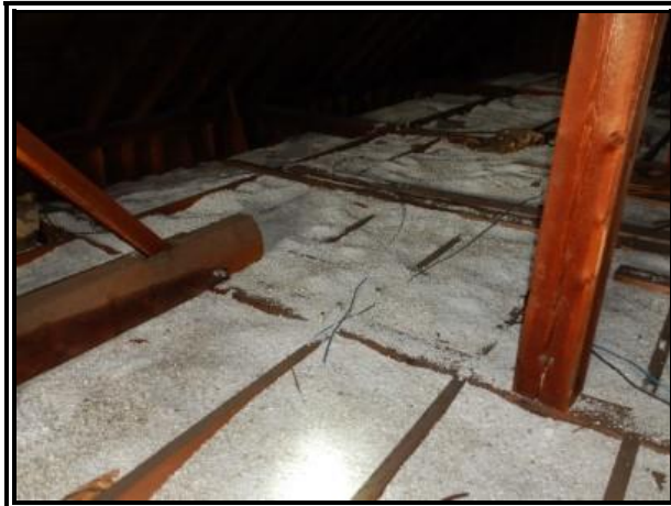
C-48 : CG 536 toiture
