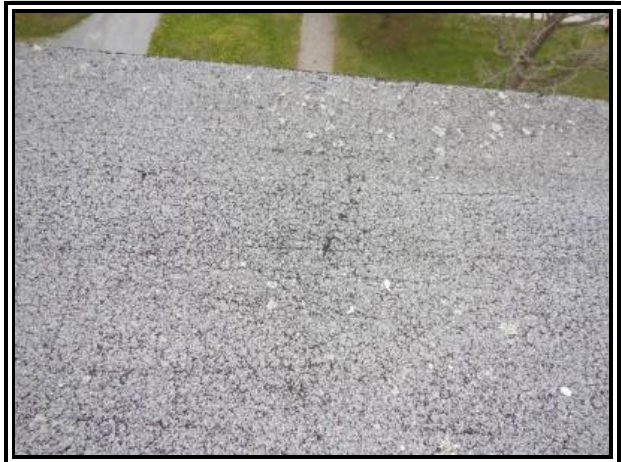
C-117 : CG 506 toiture
