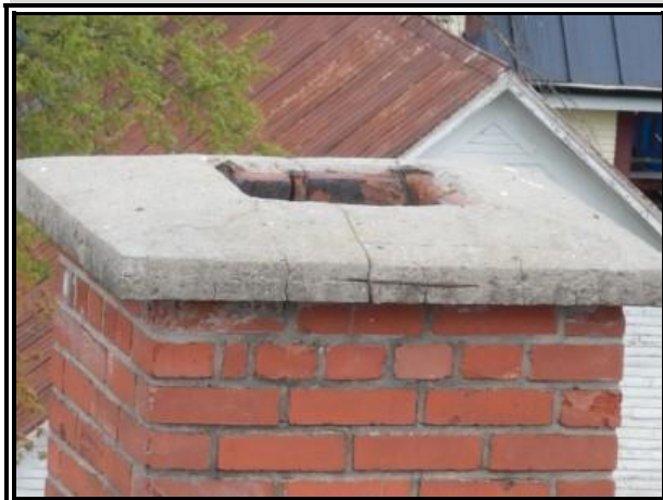
C-209 : CG 515 toiture
