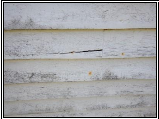
C-53 : CG 292 façade arrière
