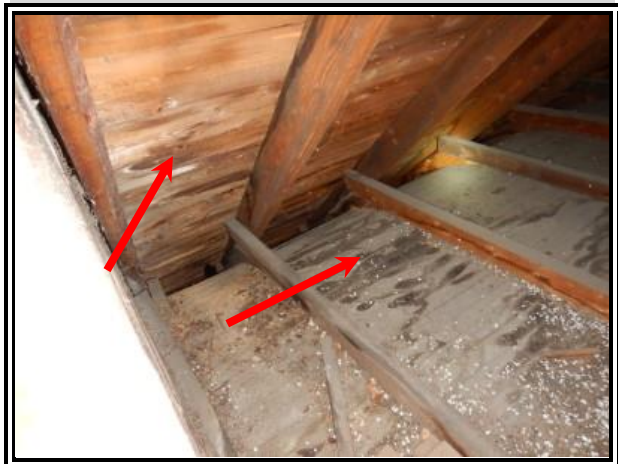
C-41 : CG 546 toiture
