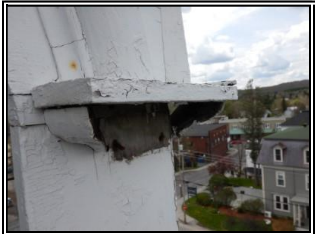
C-135 : CG 521 toiture
