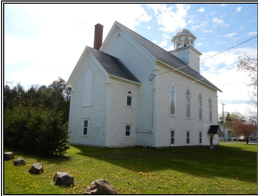
C-4 : Façade arrière
