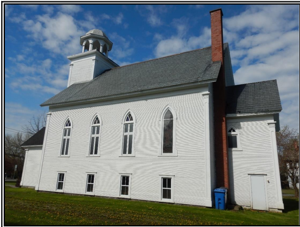
C-5 : Façade latérale droite
