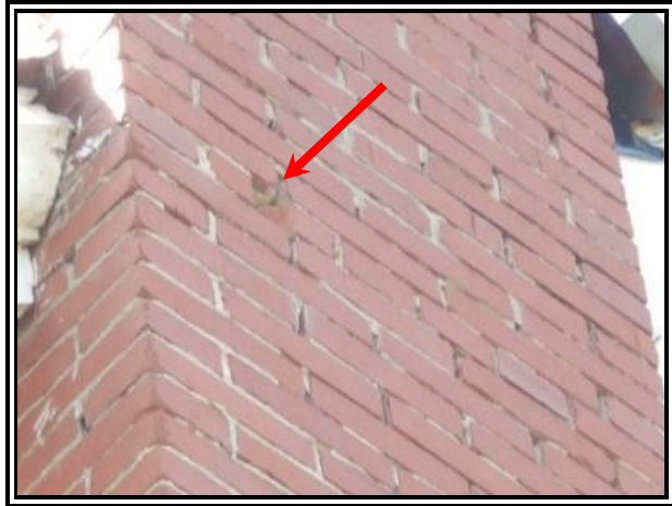
C-206 : CG 302 façade arrière
