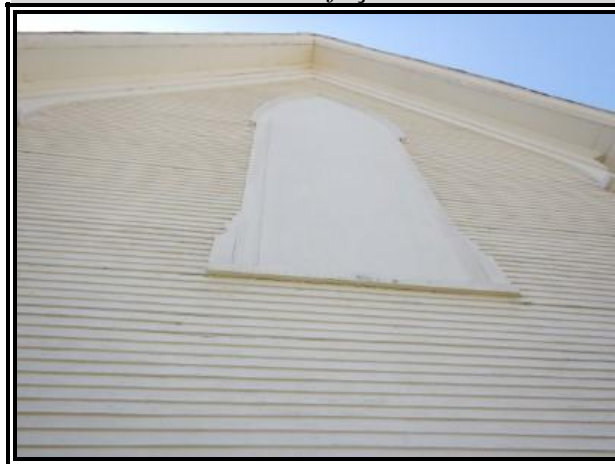
C-107 : CG 293 façade arrière
