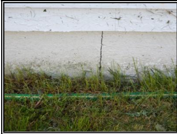
C-16 : CG 289 façade arrière
