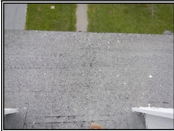
C-116 : CG 505 toiture
