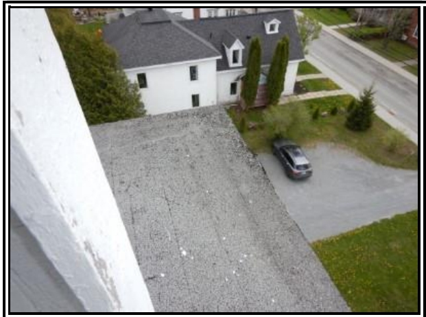
C-115 : CG 504 toiture
