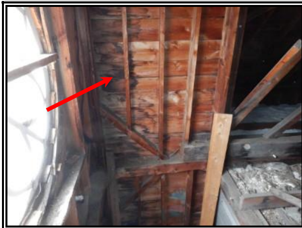
C-44 : CG 483 toiture
