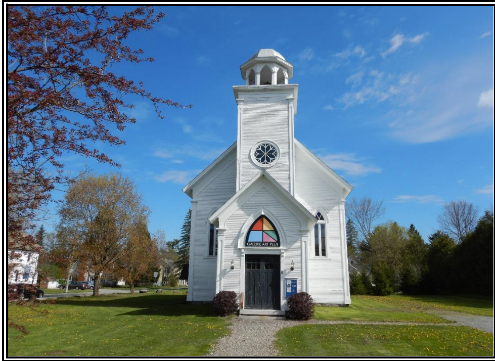
C-2 : Façade avant
