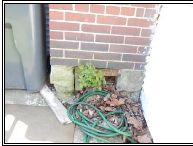
C-28 : CG 307 façade arrière
