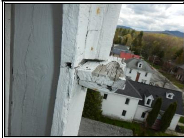
C-134 : CG 503 toiture
