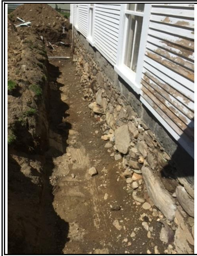
CP-2 : Aperçu des fondations après les travaux d'excavation
