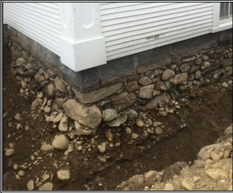
CP-1 : Aperçu des fondations après les travaux d'excavation
