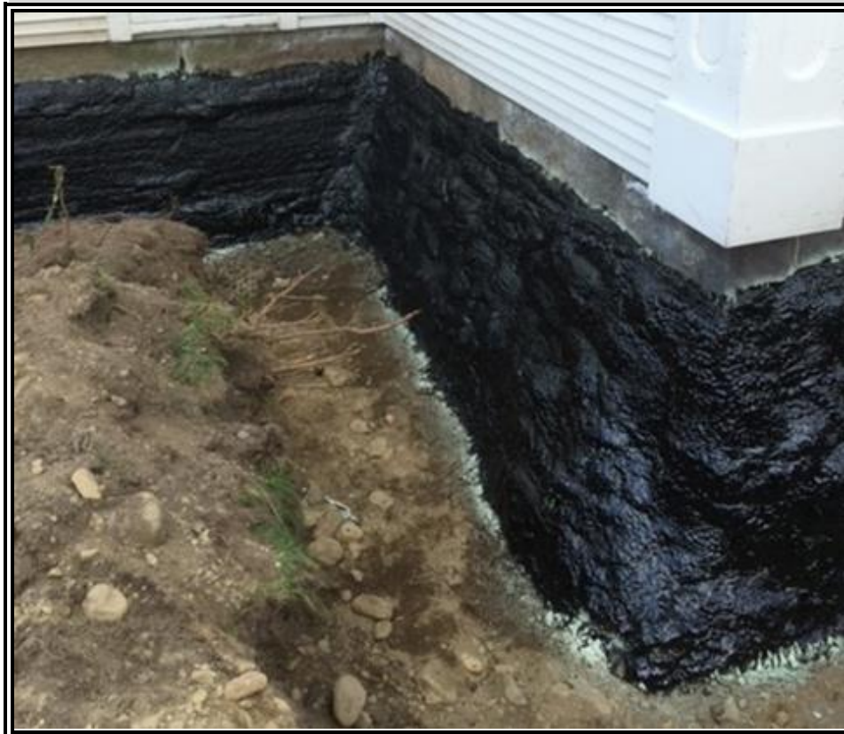
CP-4 : Aperçu des fondations après l'application de la membrane hydrofuge
