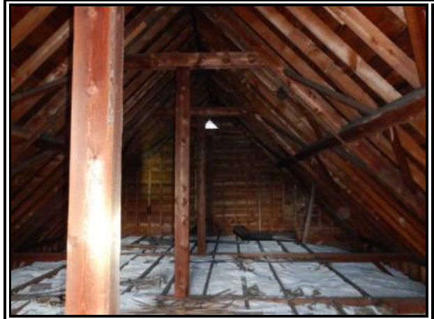
C-46 : CG 532 toiture
