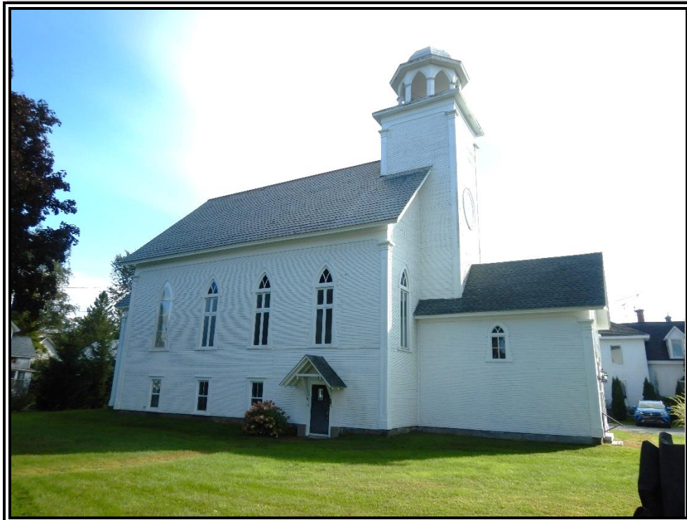
C-2 : Façade latérale gauche (2023)
