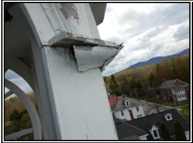
C-138 :CG 502 toiture
