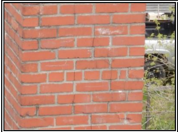
C-207 :CG 517 toiture
