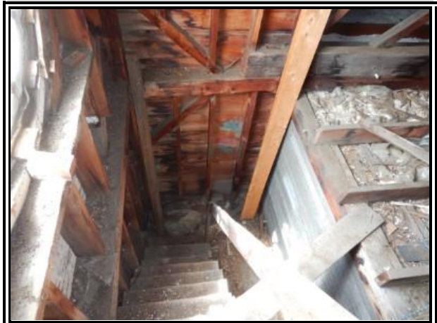
C-44 : CG 484 toiture
