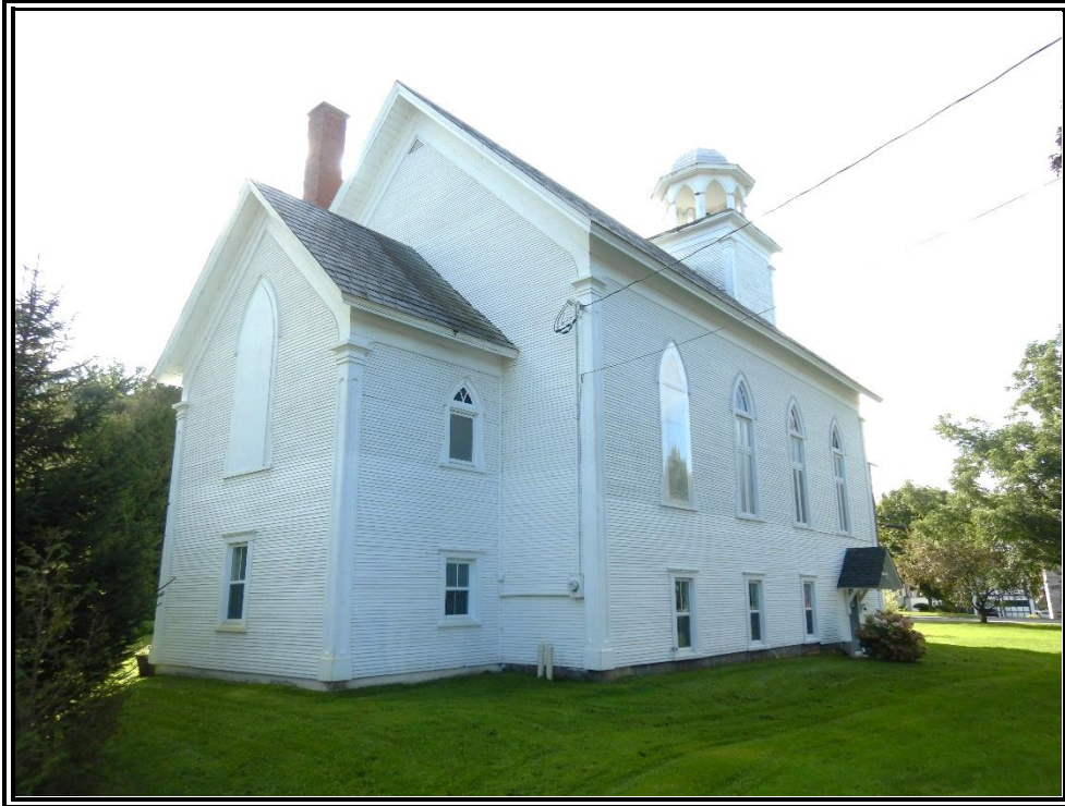
C-3 : Façade arrière (2023)
