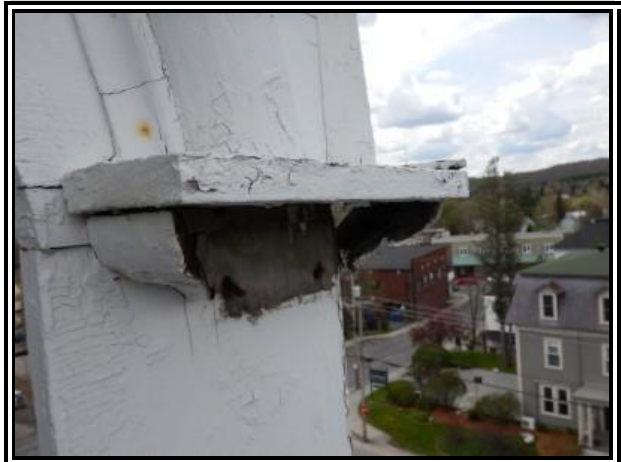
C-140 :CG 521 toiture
