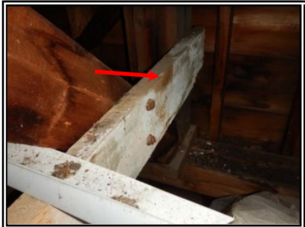
C-42 : CG 525 toiture
