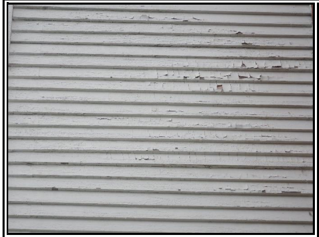
C-70 : Façade arrière (2023)
