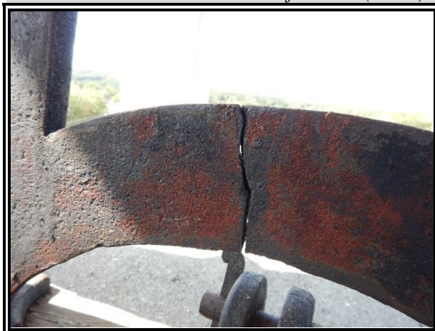
C-57 : Structure de la cloche fissurée (2023)
