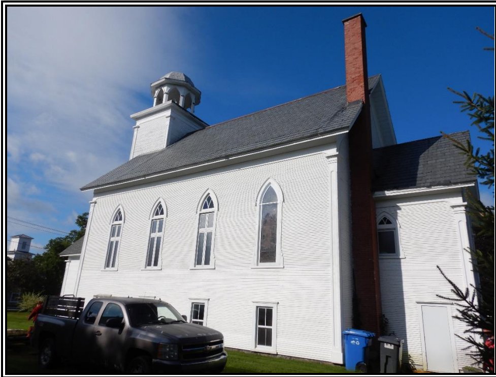
C-4 : Façade latérale droite (2023)
