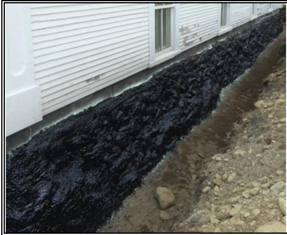
CP-3 : Aperçu des fondations après l'application de la membrane hydrofuge
