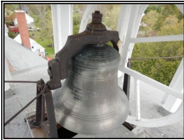
C-159 : CG 510 toiture
