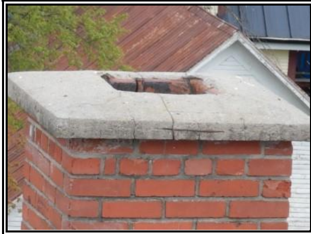
C-206 : CG 515 toiture
