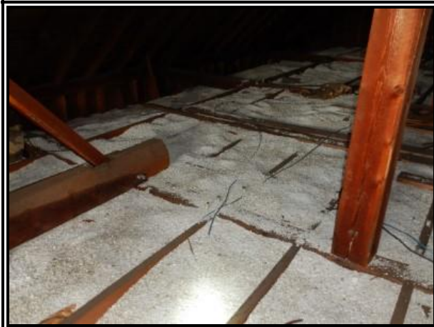
C-47 : CG 536 toiture
