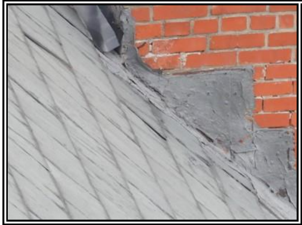
C-201 : CG 518 toiture
