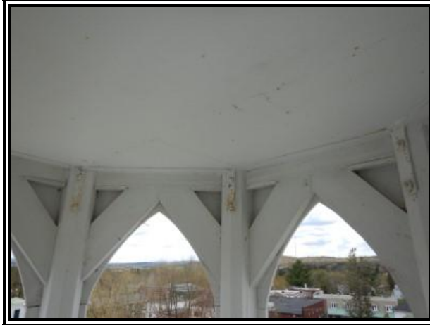
C-137 : CG 495 toiture
