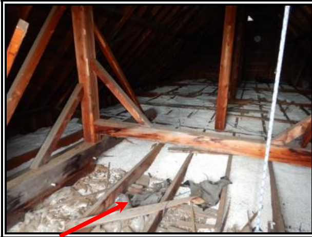
C-161 : CG 486 toiture
