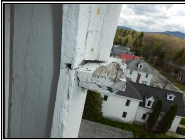
C-139 : CG 503 toiture
