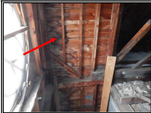
C-43 : CG 483 toiture
