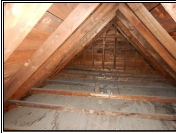
C-39 : CG 543 toiture
