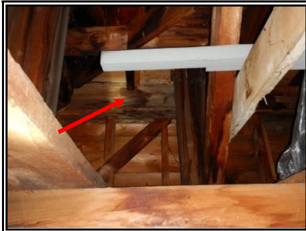
C-41 : CG 526 toiture
