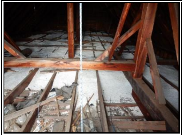
C-162 : CG 487 toiture
