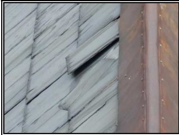
C-155 : CG 519 toiture
