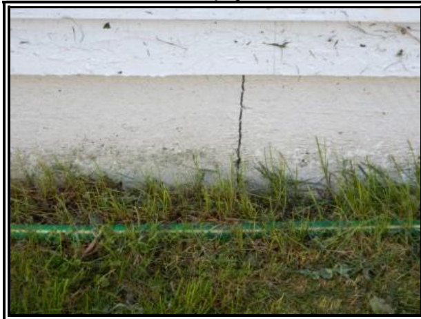
C-15 :CG 289 façade arrière
