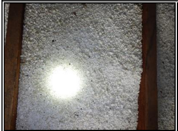
C-48 : CG 535 toiture
