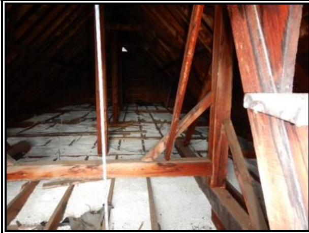
C-45 : CG 489 toiture
