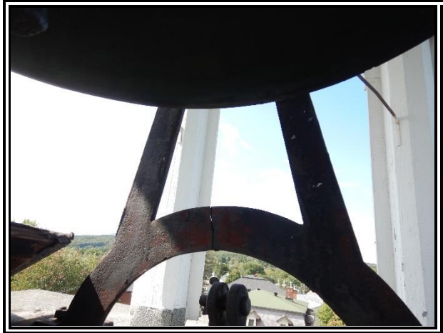
C-54 : Structure de la cloche fissurée (2023)
