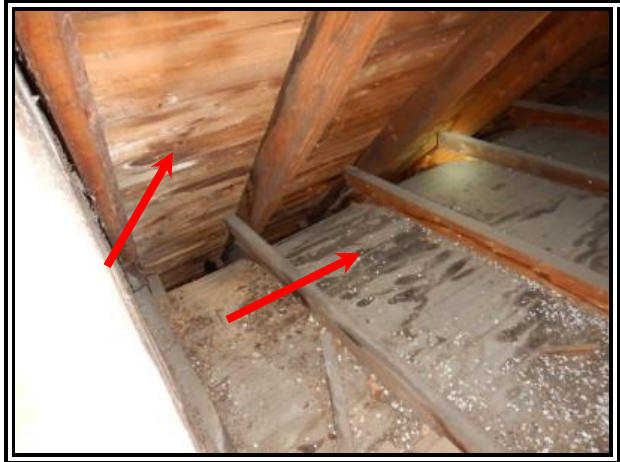
C-40 : CG 546 toiture
