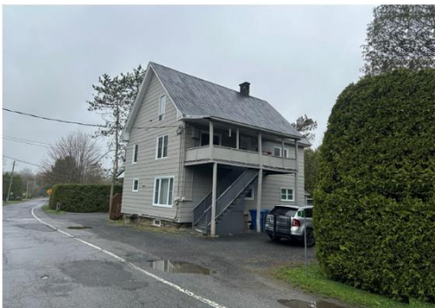
Bâtiment principal : 1, rue Gagné
